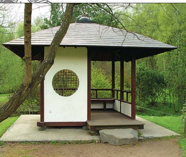
Эту беседку создал японский архитектор Такео Адачи
